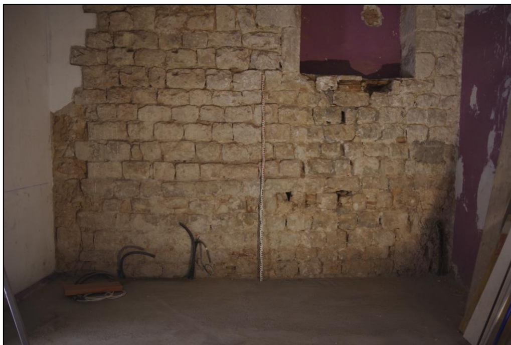
Tapiat de l'OB-13 i reparació MR-5 al primer pis
