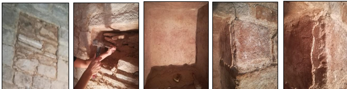
Procés d'alliberació i consolidació del lliscat de la finestra E de la primera planta.
