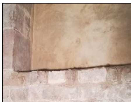
Procés de reconstrucció de l'ampit de la finestra O de la primera planta.
