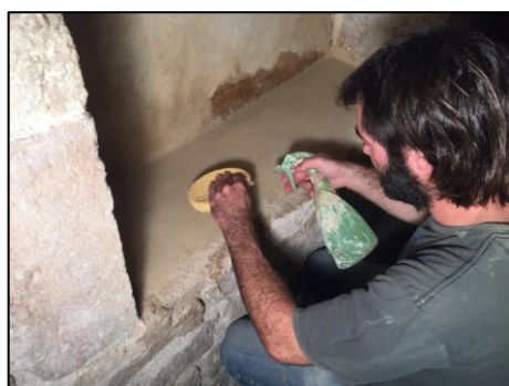
Procés de reconstrucció de l'ampit de la finestra O de la primera planta.
