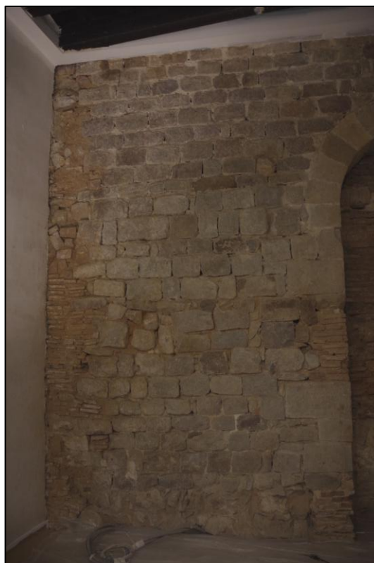
MR-1 al pis principal, amb la reparació MR-5
