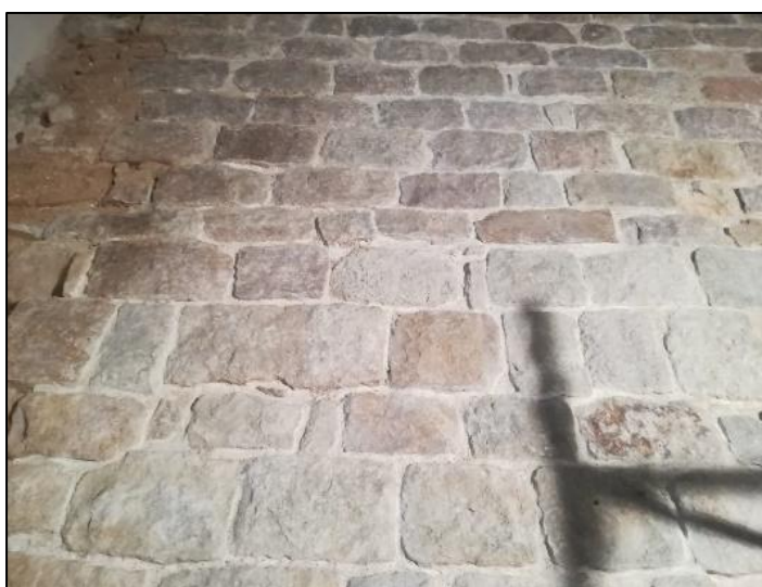
Procés de reintegració de juntes i morters de rebliment.
